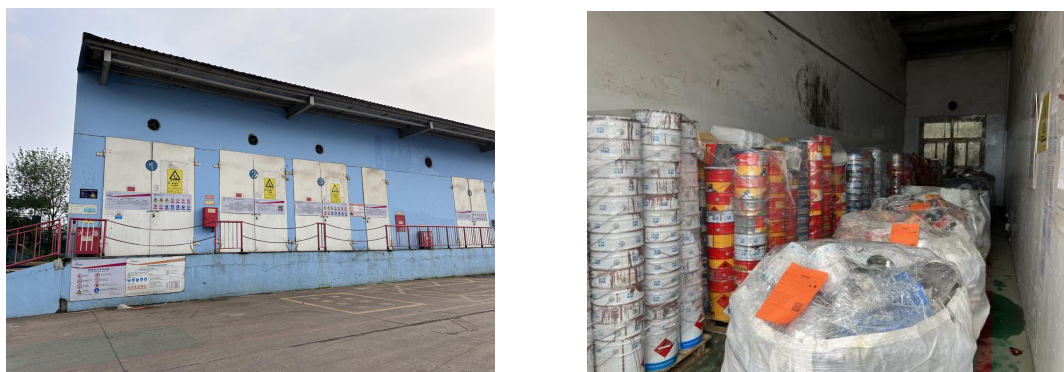
图 4.4-1 固废暂存设施照片
